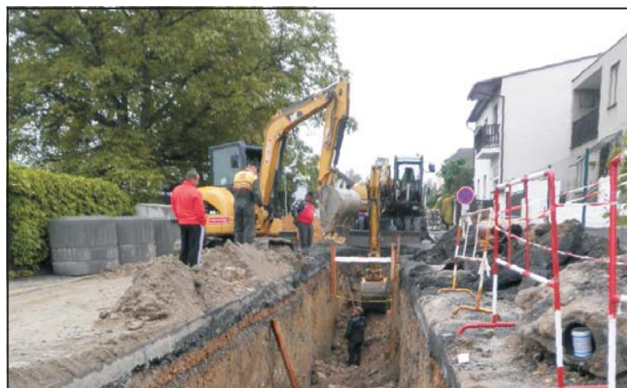
Výstavba kanalizace v ul. Za Hřbitovem
