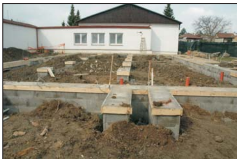
Konec března 2010: Základy přístavby
