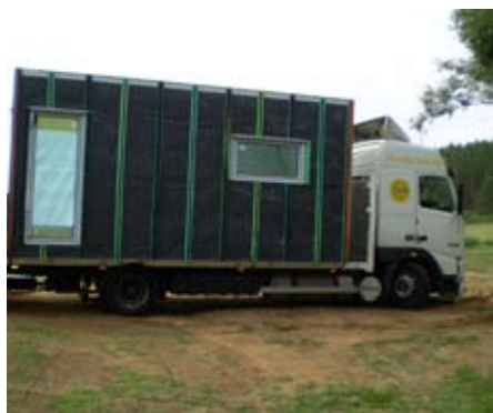
Část domu – modul – který na parcelu dopraví kamión rovnou z montážní linky
