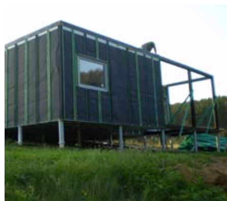
K usazeným modulům CUBESPACE se přímo na staveništi montují další prvky – třeba pergoly, terasy apod., na rastr se může začít aplikovat obklad fasády
