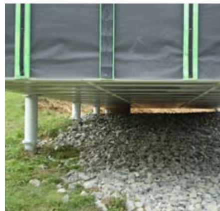
Takto pak vypadá kostka usazená na zemních vrutech ve svažitém terénu. Odpadá hloubení základové spáry, stavba se obejde bez betonáže, zdění a dalších mokrých procesů
