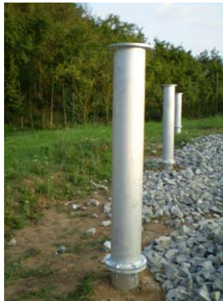
Zemní vruty Krinner se do terénu „šroubují“ buďto ručně, nebo pomocí speciálních zemních strojů. Proces montáže je v obou případech poměrně jednoduchý, a hlavně rychlý
