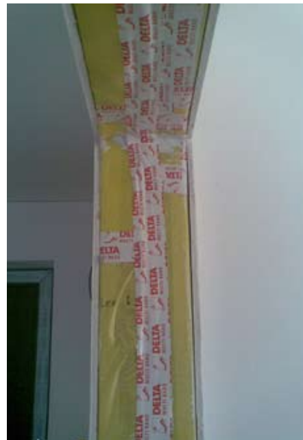
Místo styku dvou modulů může tvořit místo následné montáže otvorových výplní, třeba dveří. Na snímku je vidět tloušťka vnitřní izolace
