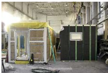
Moduly vznikají ve výrobních halách, kde se postupně skládají z prvočinitelů. Základní stavební jednotkou systému je kostka, tvarově spíš hranol s přesně stanovenými rozměrovými parametry
