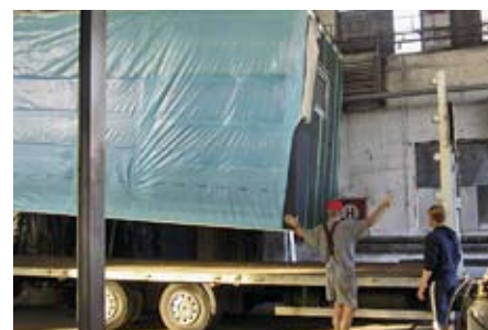
V montážní hale se moduly naloží na kamión, odvezou na stavební parcelu a tam se zkompletují. Dům je připraven k nastěhování během několika málo dnů
