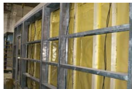
Stěny (plášť) domu díky skladbě sendvičové konstrukce s kvalitní izolací a dokonalým zateplením splňují kritéria a parametry nízkoenergetického bydlení
