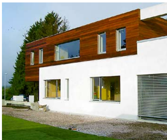
Zajímavé pojetí fasádní plochy tvořené z části dřevěným obkladem s příznanými spárami do 20 % plochy; větotěsná a zároveň pojistně hydroizolační vrstva z materiálu DELTA-FASSADE
