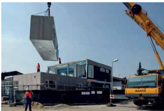
Materská škola, Praha – Dubeč, priebeh výstavby a dokončená budova, architekt: Cubespace
